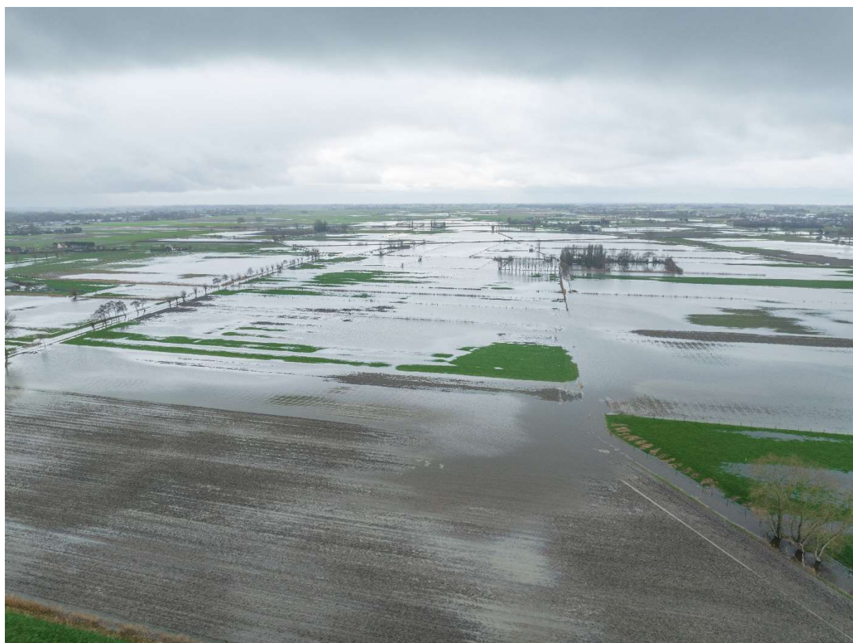
Centrale Loop Nieuwland Moere
