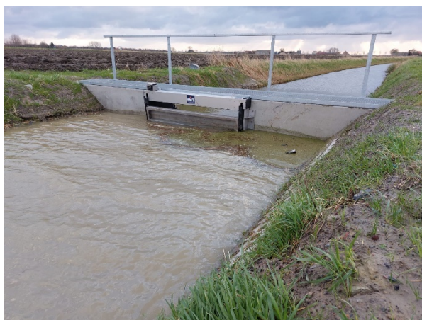
Afgewerkte klepstuw incl. loopbrug en leuning
