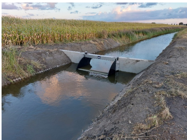
Afgewerkte klepstuw
